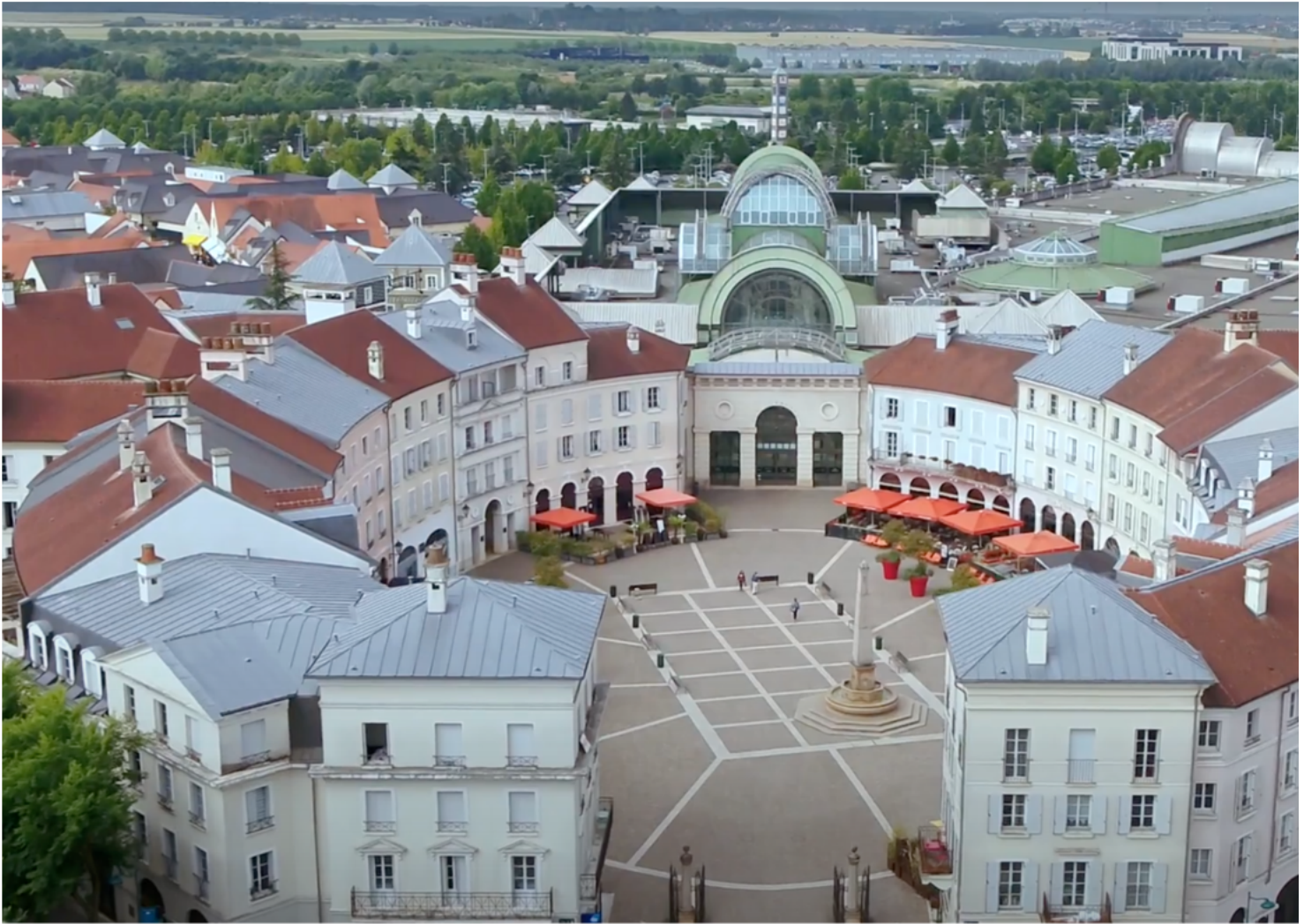
Figure 3 : Centre commercial de Val d'Europe, EPA Marne
