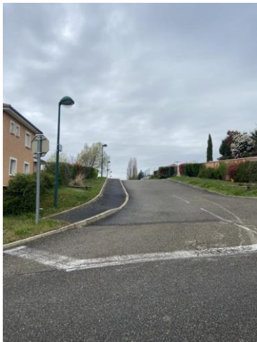
Figure 2 : Arrêt net des trottoirs
