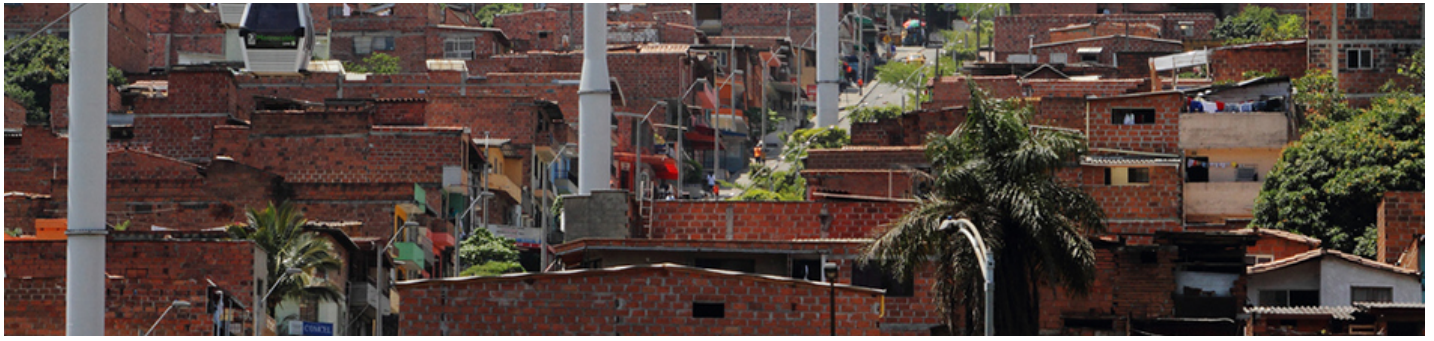
Figure 1 : Le Metrocable de Medellín, comunas 1 et 2.
