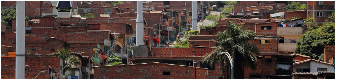
Figure 1 : Le Metrocable de Medellín, comunas 1 et 2.
