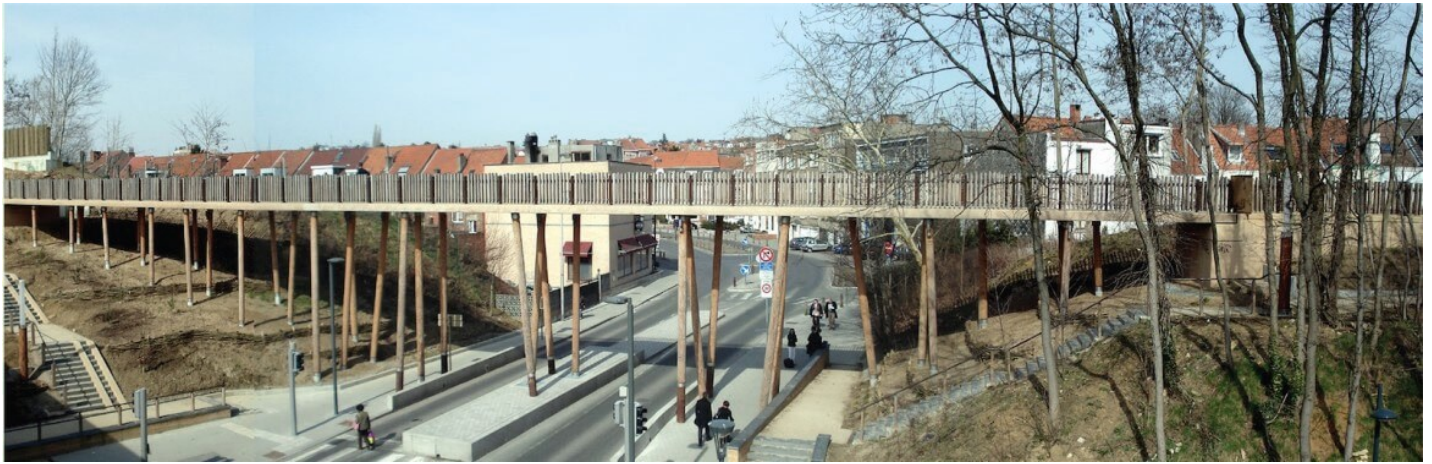
Figure 9 Exemple d'infrastructure cyclopédestre urbaine séparée, aménagée sur le tracé d'une ancienne voie ferrée se situant en hauteur par rapport à la rue. La Promenade du Chemin de Fer, 2010. © Dessin et Construction.
