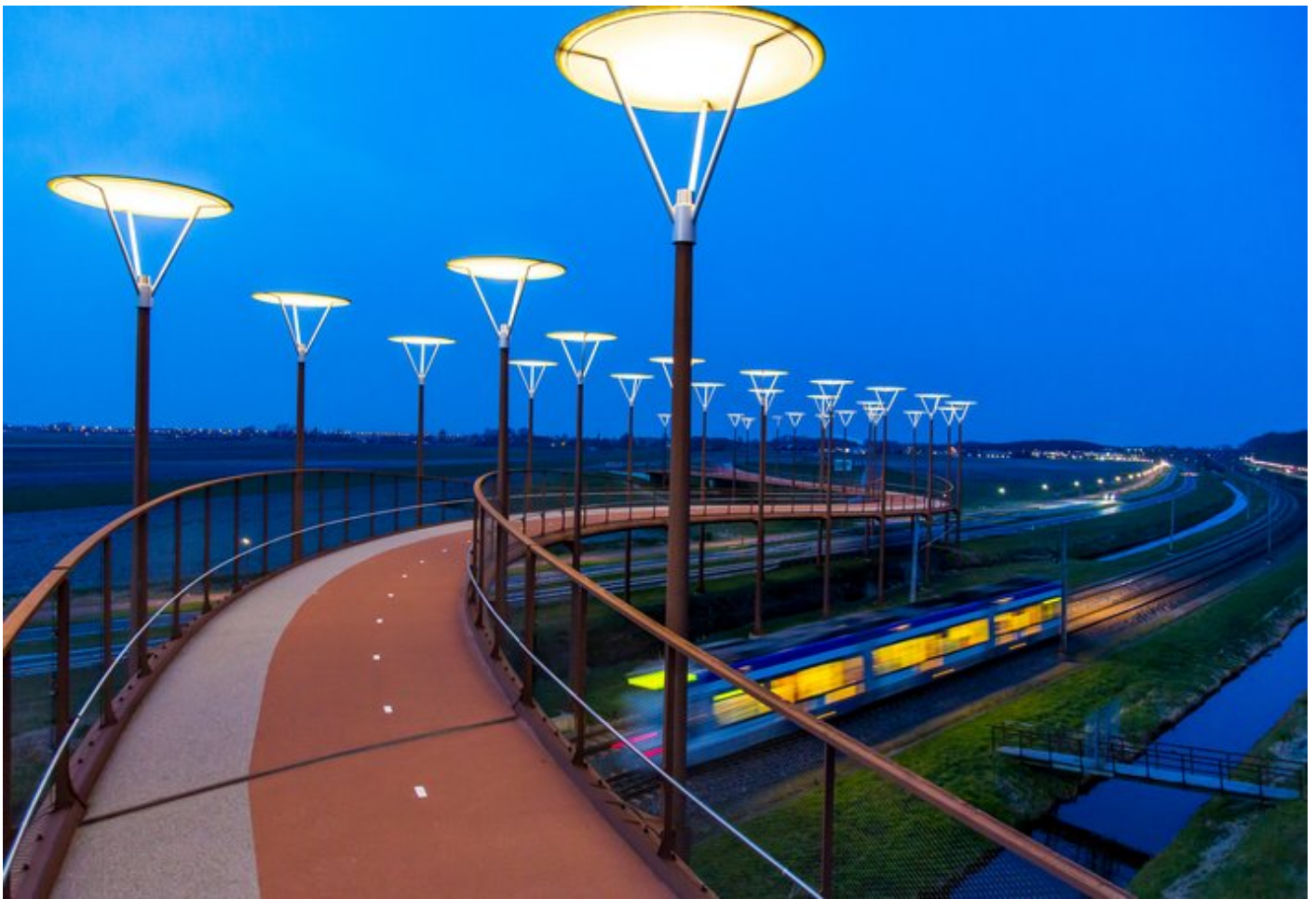
Une piste cyclable sur un pont de 220 mètres de longueur au-dessus d'une autoroute et d'une voie ferrée dans la future réserve naturelle de New Driemanspolder à Zoetermeer. Crédit : Jochen Tack / Alamy
