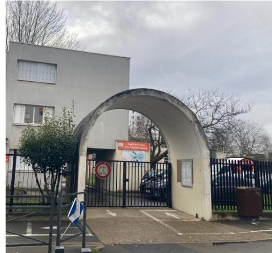
Figure 13 : Entrée de l'école des Cosmonautes à Saint-Denis
