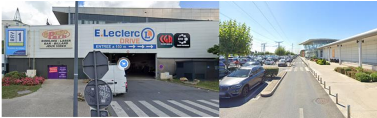
Figure 24. Les centres commerciaux Bay 1 et Bay 2, pour lesquels les espaces publics autours ont moins été soignés que les centres commerciaux de Serris.
